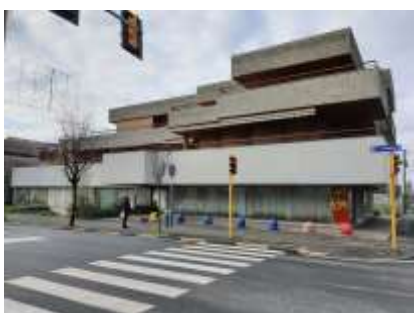
Edificio commerciale dismesso lungo Corso Roma
