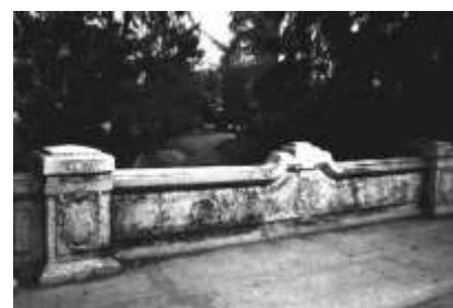
Ponte sulla Via Vittorio Veneto (Seveso)
